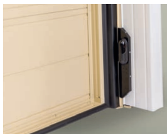
Coppia di fotocellule interne precablate e premontate sulla porta basculante. (cod. MB.16) (optional)
